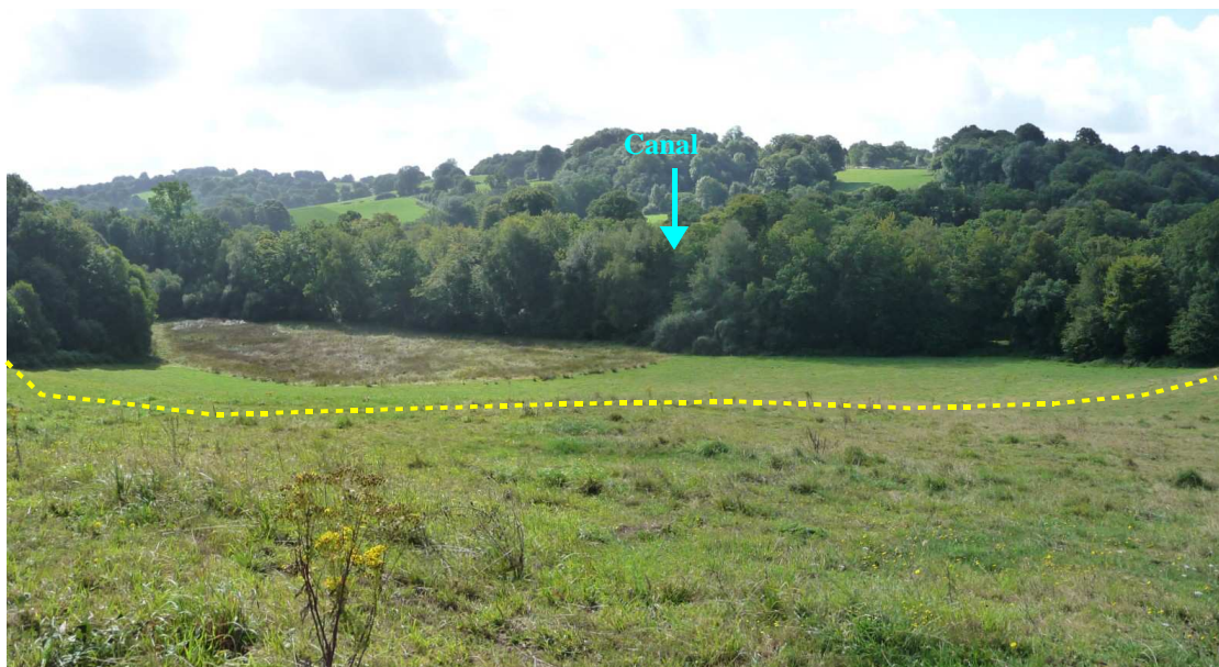
Photo 6: Vue rive gauche du canal en aval de l'écluse de Gwendol
