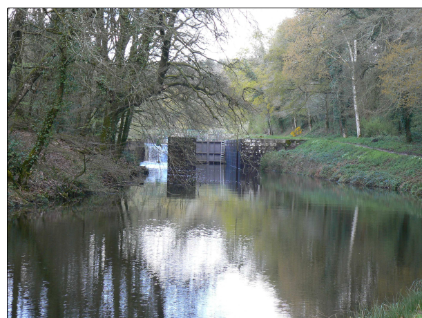
Photo 3: Ecluse de Cosquérou - Vue depuis l'aval
